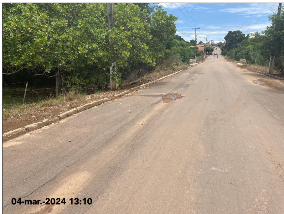
Imagem 05: Endereço – Rua Monte Castelo próximo a ponte.
