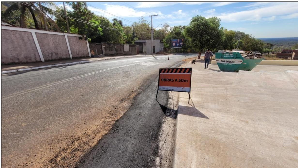
**Imagem 15:** Detalhe do trecho com a repavimentação asfáltica concluída
