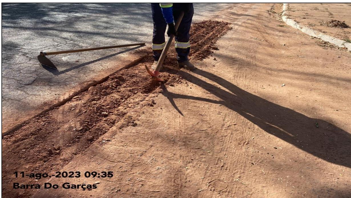
**Imagem 07:** Detalhe da limpeza da vala para imprimação.
