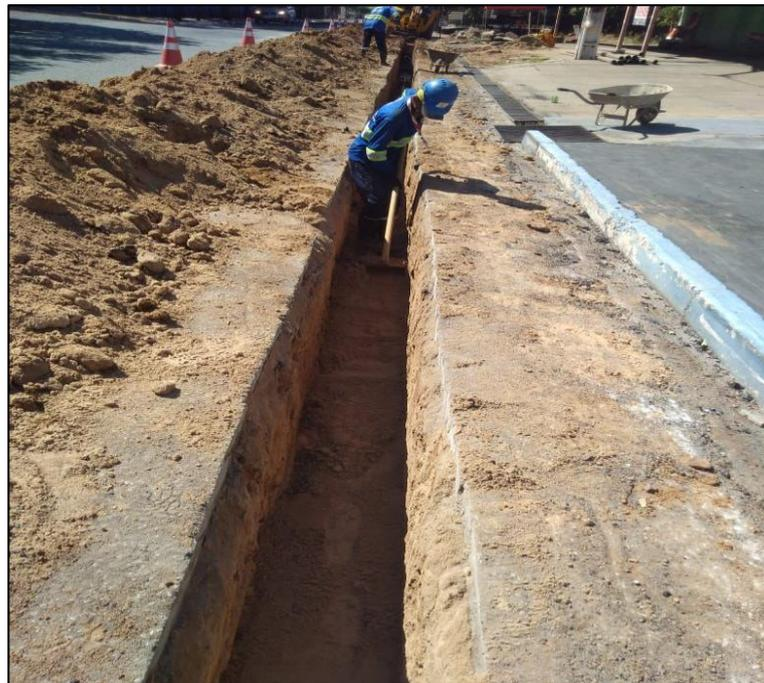
**Imagem 05:** Detalhe da preparação do solo para a compactação.
