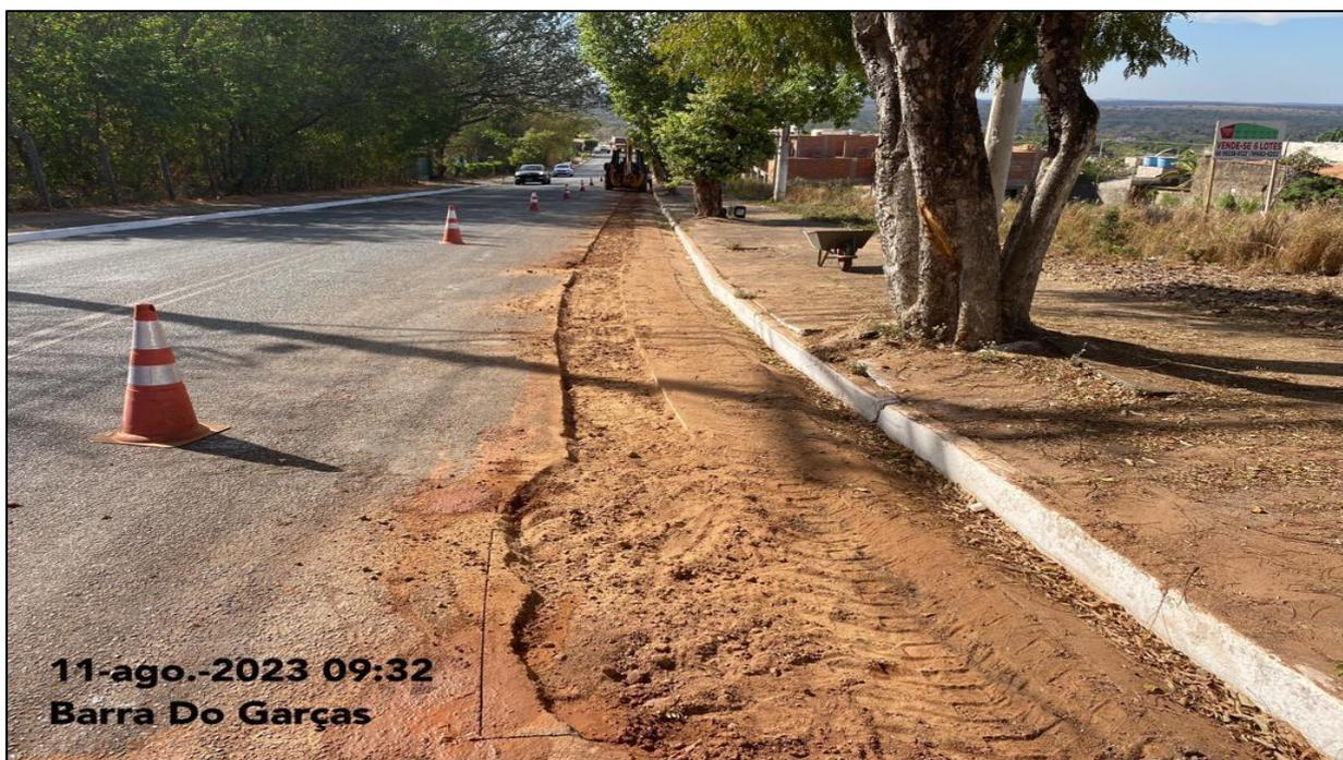
**Imagem 13:** Detalhe da marcação para o recorte do asfalto.
