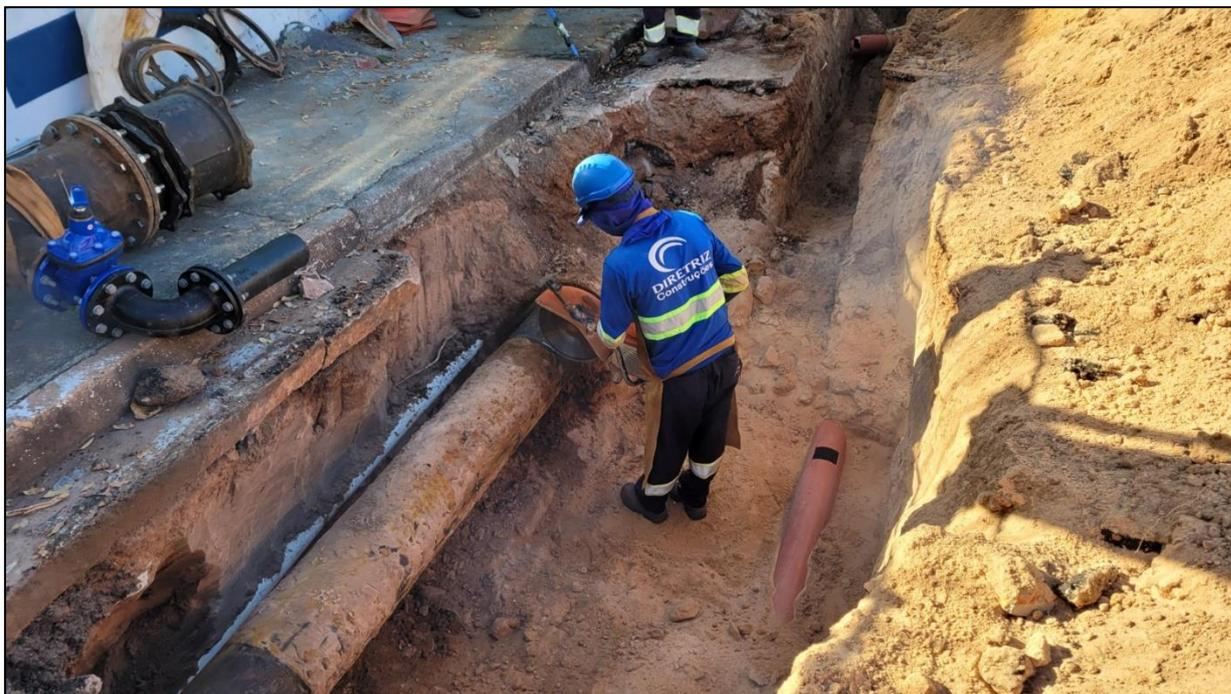
**Imagem 03:** Detalhe da interligação da nova rede na saída do reservatório do BNH.
