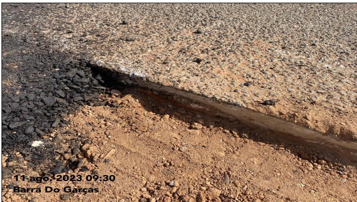
**Imagem 11:** Detalhe da altura do solo para receber o asfalto.
