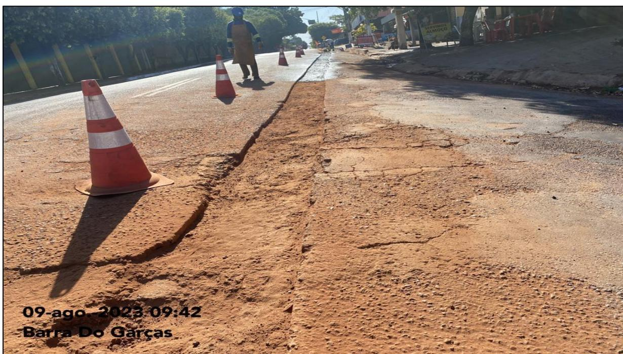
**Imagem 08:** Detalhe do solo preparado para a imprimação.
