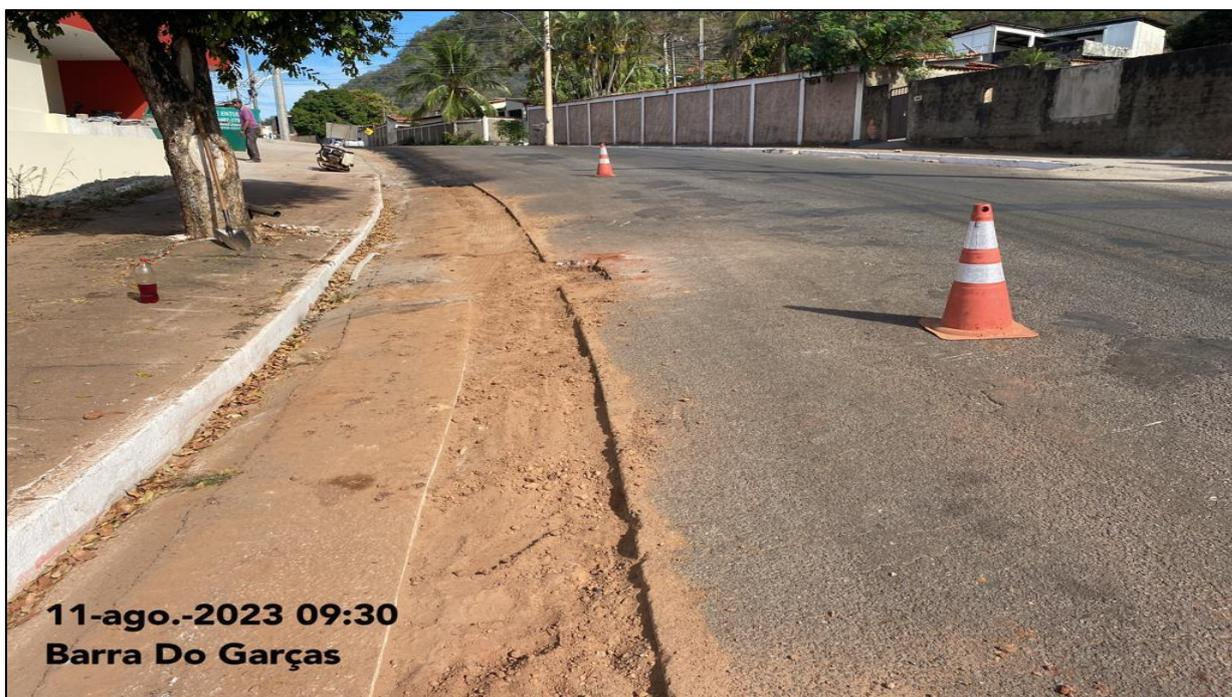
**Imagem 09:** Detalhe do solo preparado para a imprimação.
