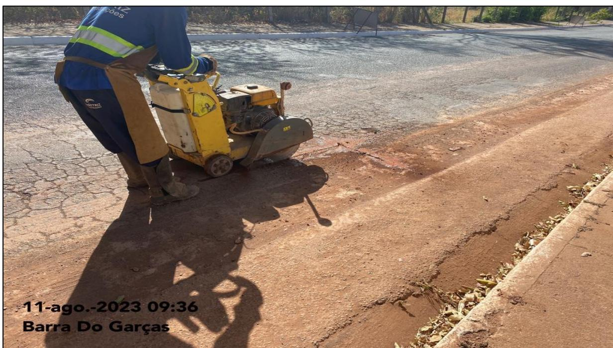
**Imagem 14:** Detalhe do recorte do asfalto para evitar infiltrações.
