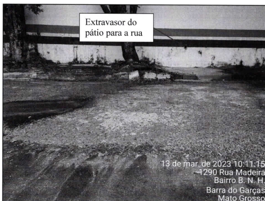
Imagem 03: Destaque para o tubo extravasor e detalhe dos sinais de extravasamento de água recente.
