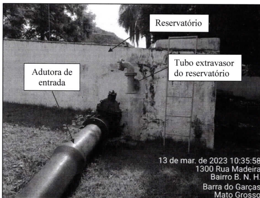
Imagem 02: Destaque para o reservatório a adutora de entrada e o tubo extravasor.
