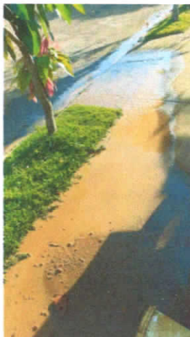
Foto do vazamento
