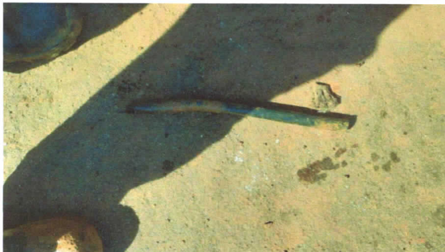
Foto do motivo do vazamento
