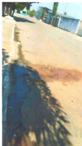
Foto do vazamento
