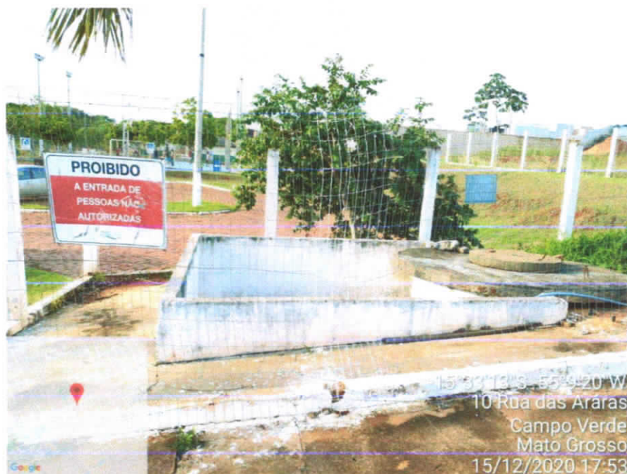
Imagem: Detalhe do alambrado reparado.
