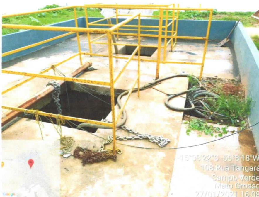
Imagem 02: Detalhe dos poços sem tampa.
