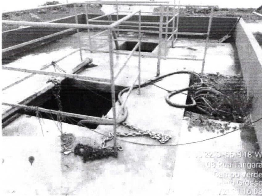
**Imagem 02:** Detalhe dos poços sem tampa.
