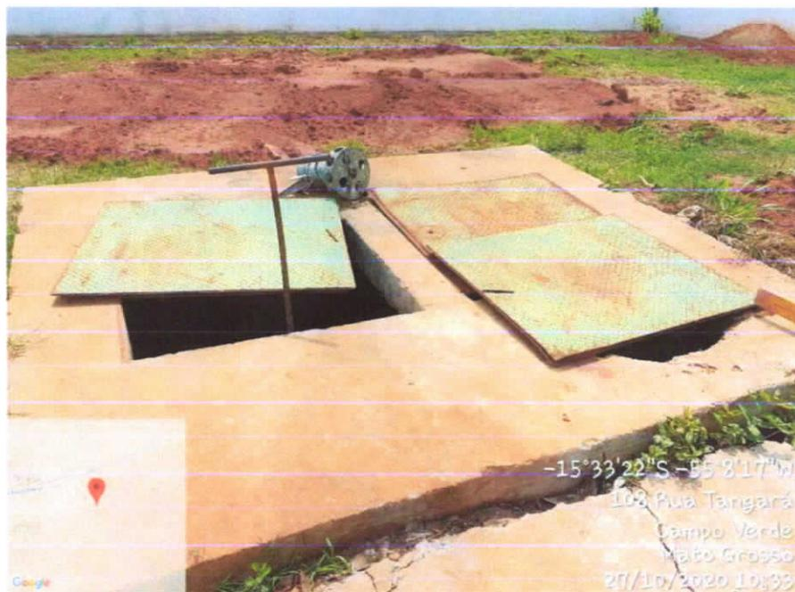
**Imagem 04:** Detalhe de poços da elevatória com tampas desencaixadas e sem grades de proteção.
