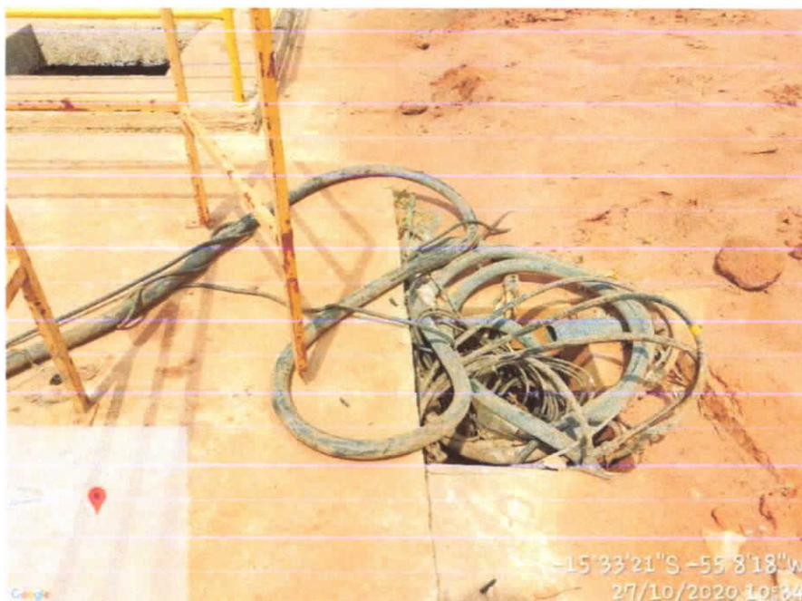
**Imagem 05:** Detalhe da caixa de proteção elétrica destampada e com fiação exposta.
