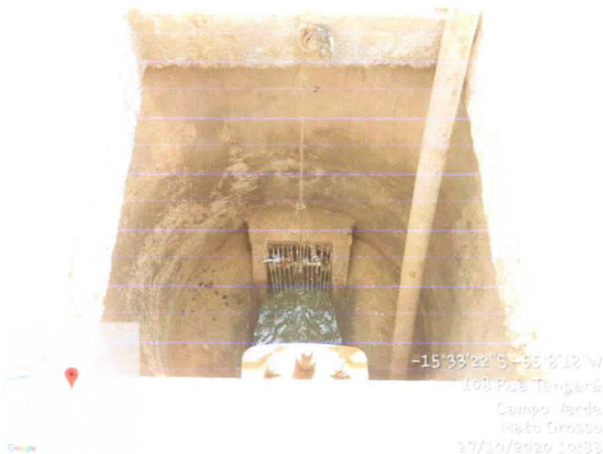
Imagem 02: Detalhe do poço do gradeamento sem tampa.
