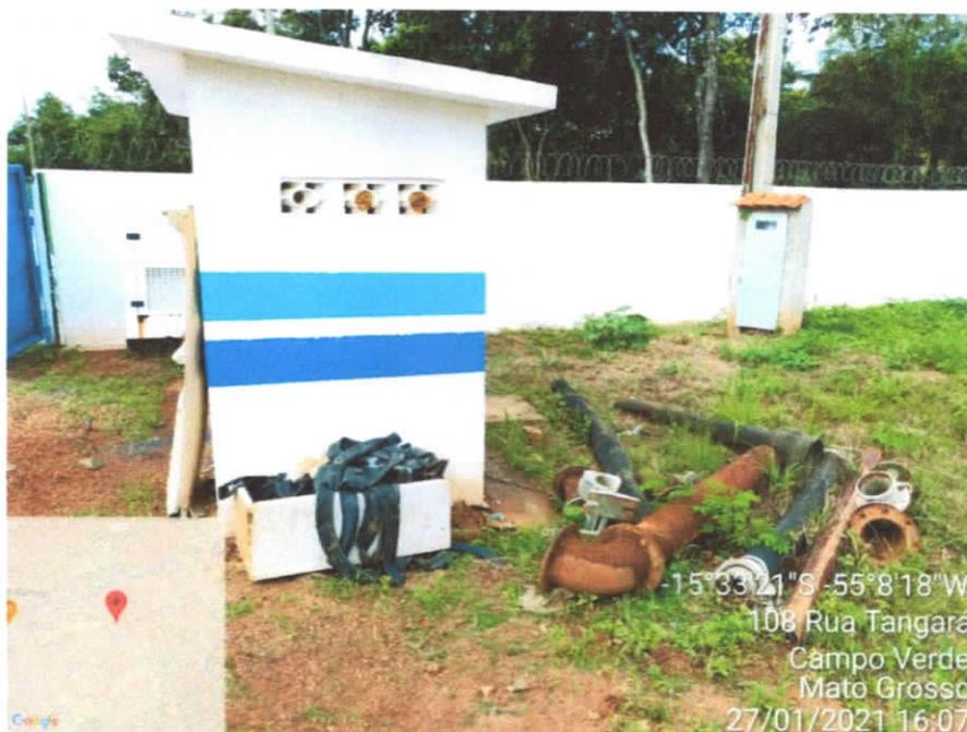
Imagem 06: Detalhe de materiais hidráulicos, sem abrigo, no pátio da elevatória.
