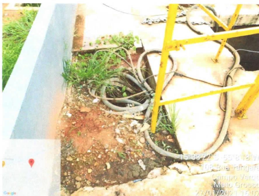
Imagem 03: Detalhe da caixa de proteção elétrica sem tampa e com fiação elétrica exposta.
