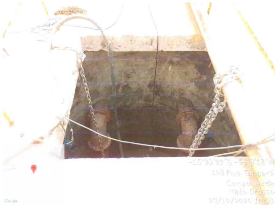
**Imagem 03:** Detalhe do poço de sucção sem tampa.
