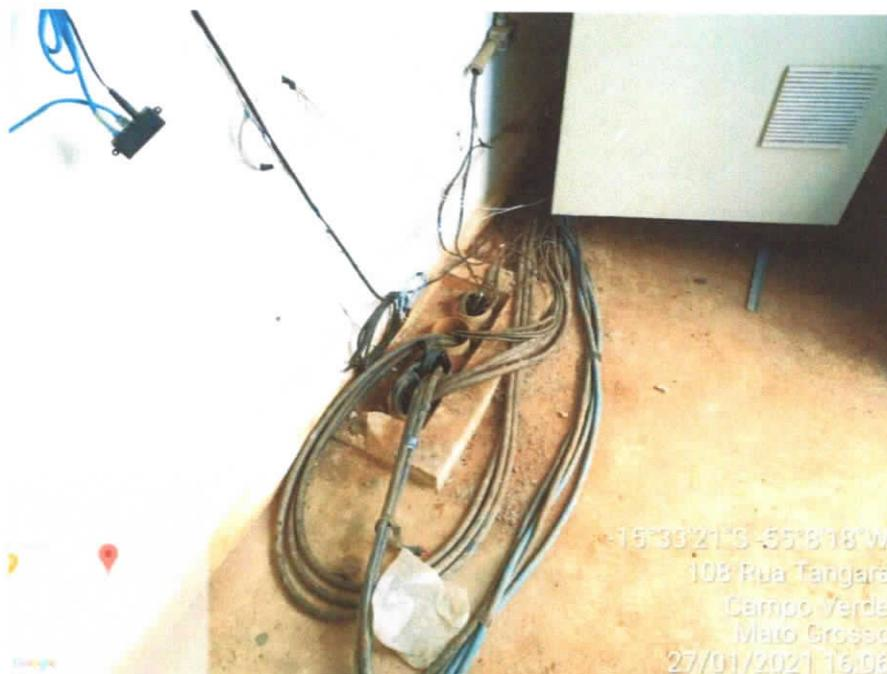
Imagem 04: Detalhe da fiação elétrica exposta na sala do quadro de comando.
