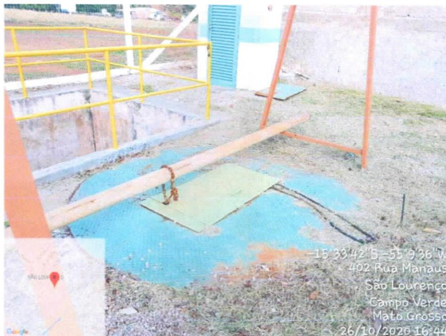
**Imagem:** Detalhe do poço de sucção fechado na EEE Eckert.
