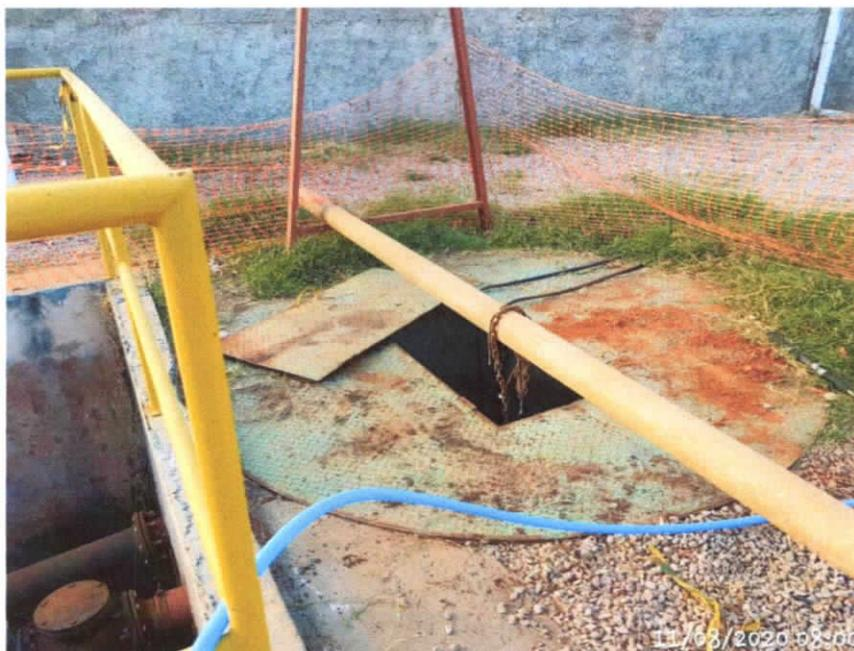
Imagem 03: Detalhe do poço de sucção aberto da EEE Eckert.
