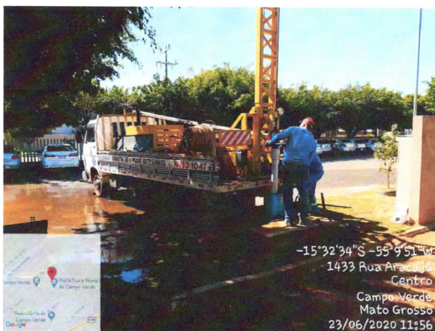
Imagem 02: Empresa contratada pela concessionária iniciando a manutenção do poço 13.
