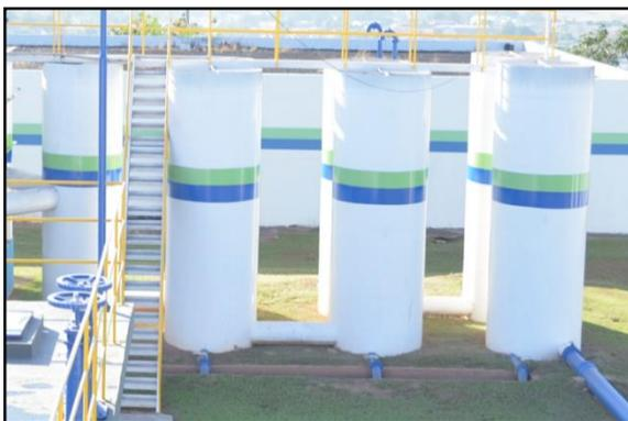
**Figura 3 – Tanques Floculadores – ETA rio Garças.**
