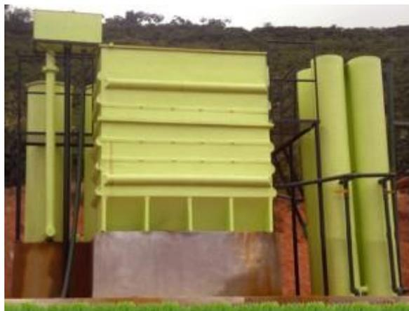
Figura 26 - ETA compacta confeccionada em PVC, fibra de vidro e polietileno. Fonte: Acquanova (2014)
