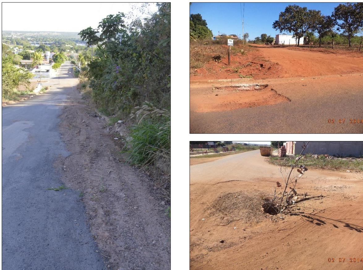
Figura 37 - Processos erosivos ocasionados pela água da chuva em Barra do Garças – MT.
