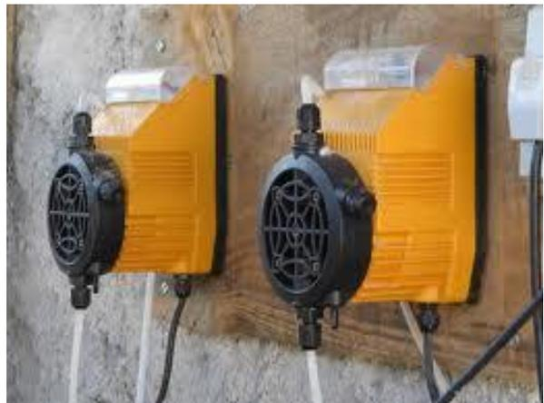
Figura 28 - Bombas dosadoras de cloro e flúor. Fonte: Limpex tecnologia ambiental (2014)
