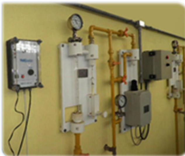
Figura 8 - Clorador automático. Fonte: FluidFeeder (2015)
